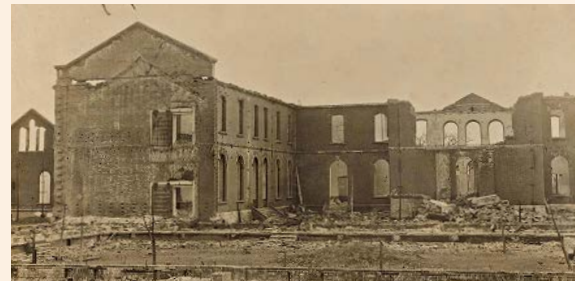
関東大震災直後の煉瓦校舎
