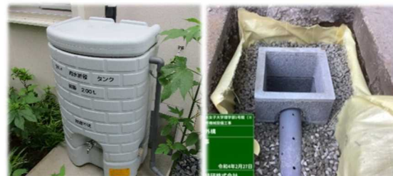
【雨水貯留タンク】
