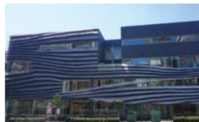
国際交流留学生プラザ (外観)
