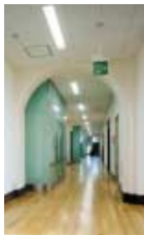
▲設備配管はガラススクリーンの中へ
