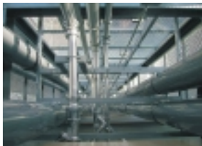
外壁のシャフトの内部
