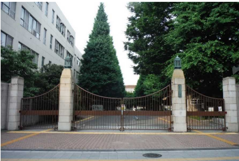
復元改修前の大学正門（平成29年4月1日撮影）
