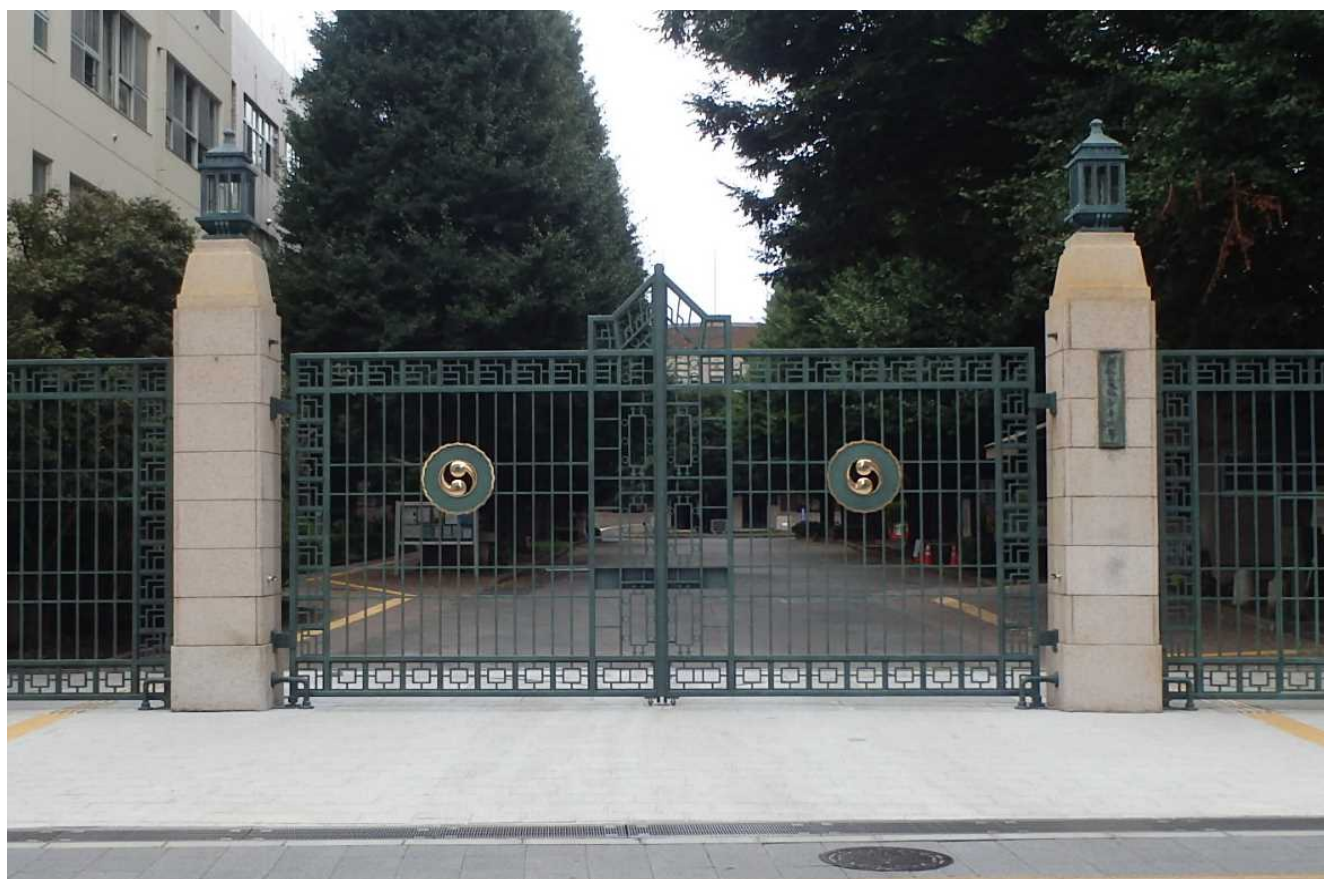
復元改修後の大学正門（平成29年8月31日撮影）
