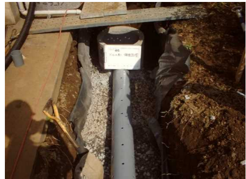
雨水配管の設置
